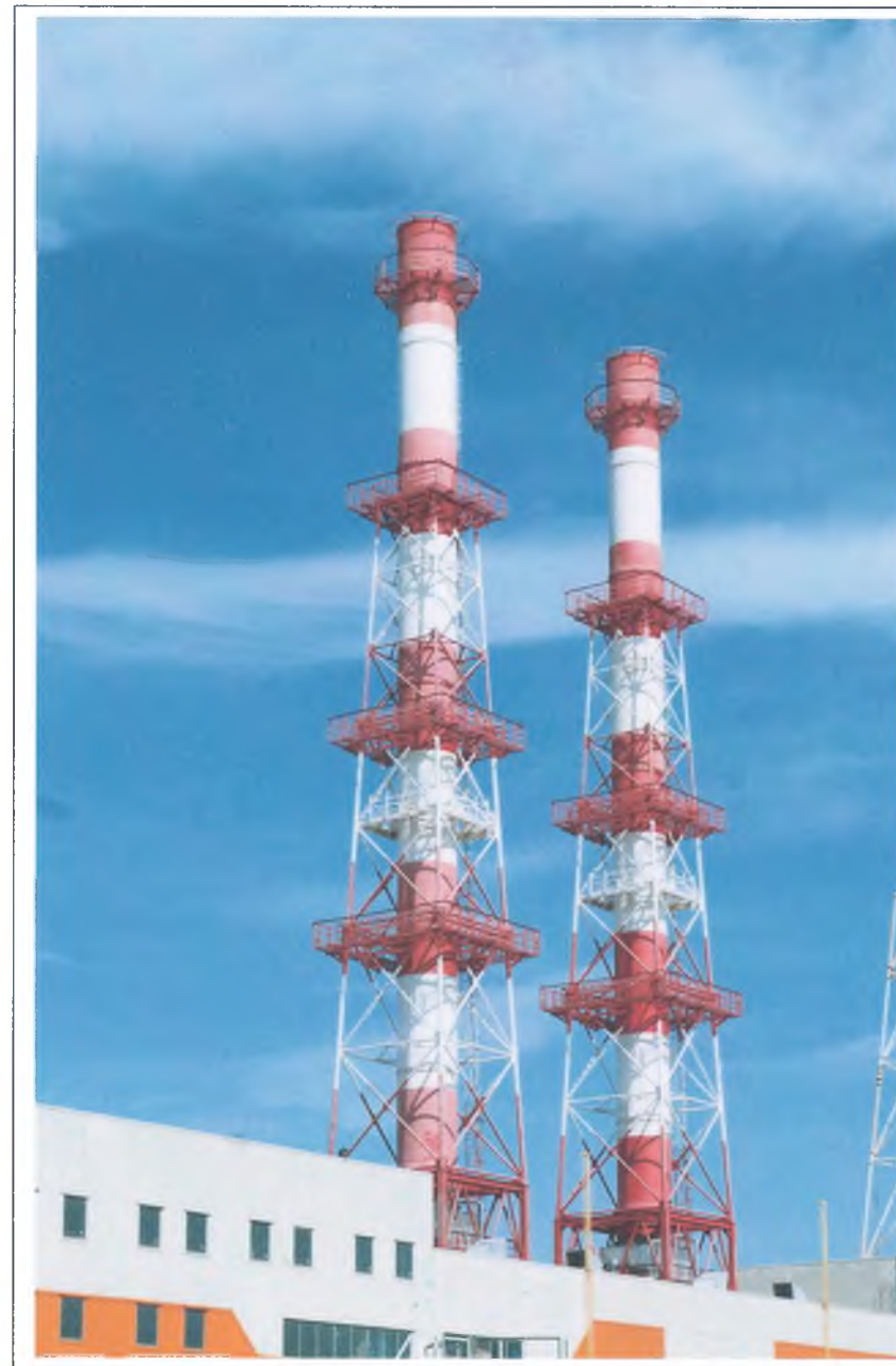
г.Москва, Филиал №1 «Западный», ОАО «МОЭК», ГТЭС «Внуково»
