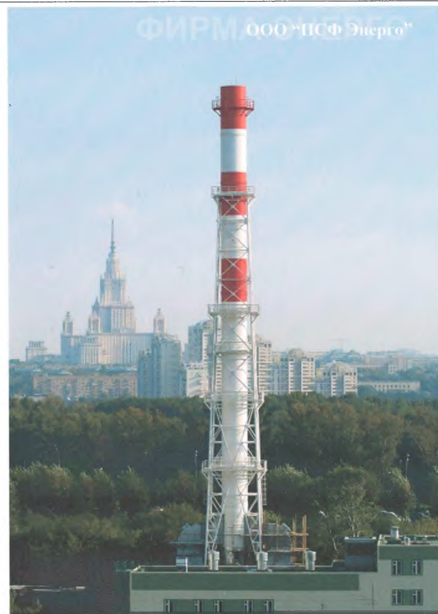
Филиал №8 «Западный» ОАО «МОЭК» г.Москва, КТС-24
