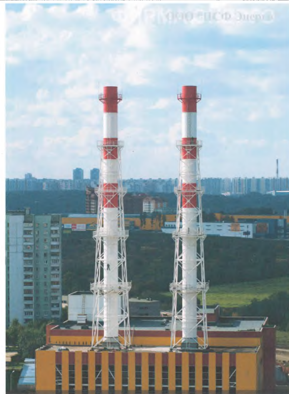
г.Москва, Филиал №4 «Северо-Западный», ОАО «МОЭК», РТС «Тушино-5»
