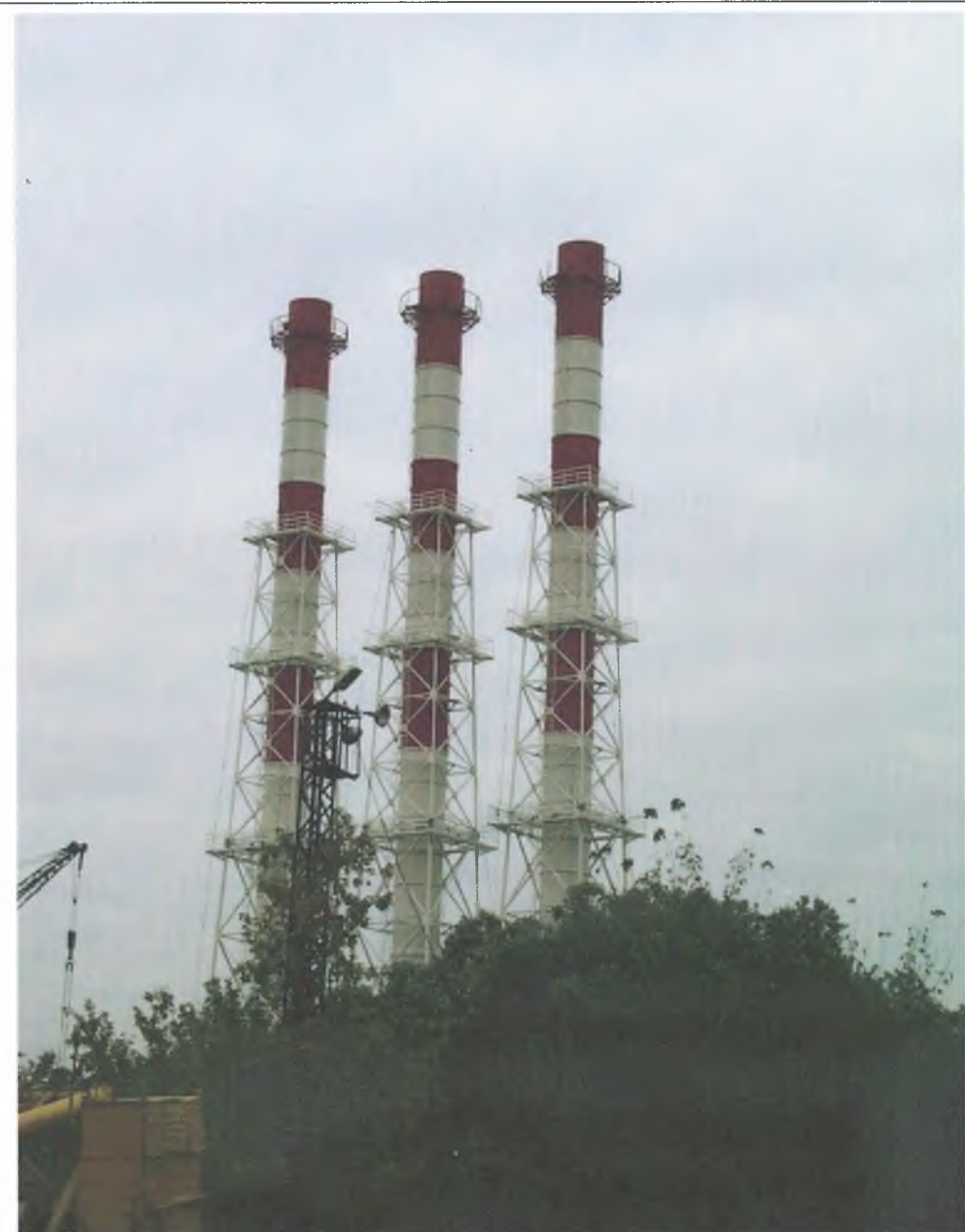
г.Москва, Филиал №8 «Западный», ОАО «МОЭК», РТС «Матвеевская»
