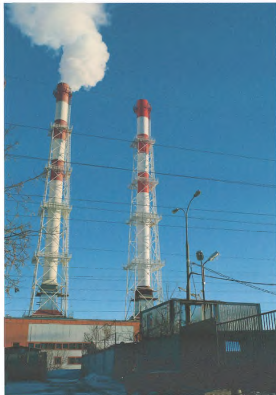
г.Москва, Филиал №4 «Северо-Западный», ОАО «МОЭК», РТС «Химки-Ховрино»
