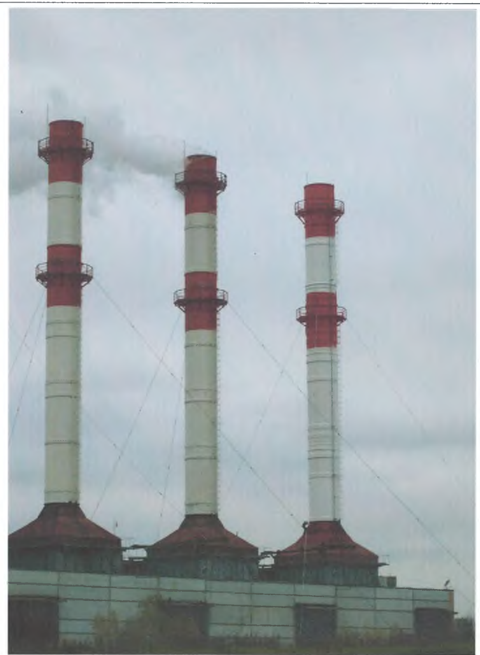
г.Москва, Филиал №5 «Юго-Восточный», ОАО «МОЭК», РТС «Фрезер»
